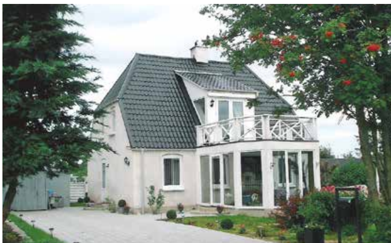
Huset efter den omfattende restaurering i 2012.
