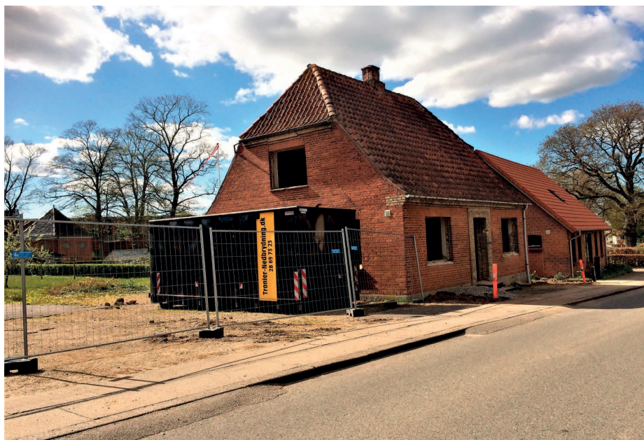
Under klargøring til nedrivning.
