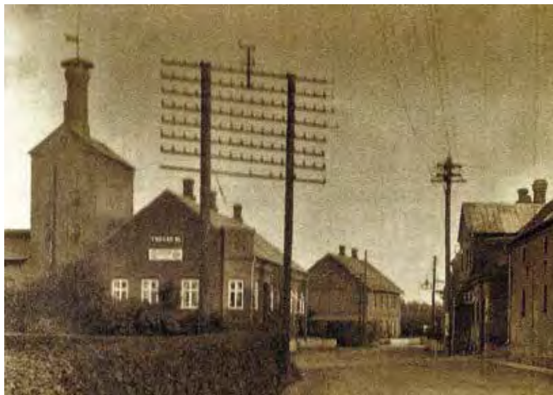
B2767. Dengang var der luftledninger der ville noget.
